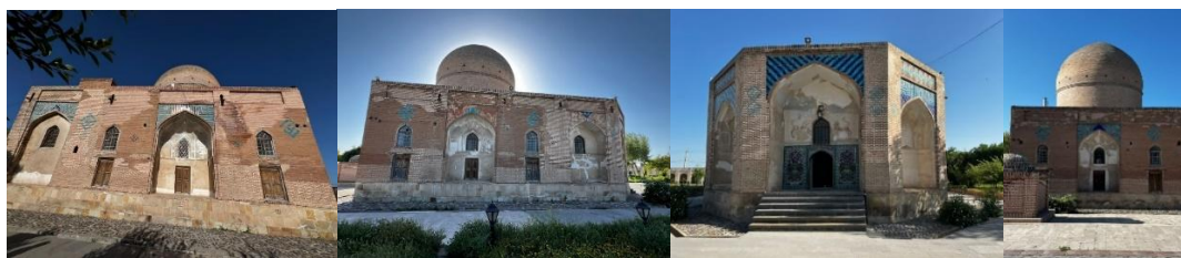
شکل ۴. ایوان جنوبی شکل ۵. ایوان شمالی شکل ۶. ایوان شرق شکل ۷. ایوان غربی
